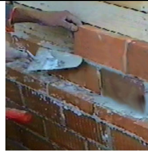
6 - inizio delle fasi di posa dal piano di imposta laterale
