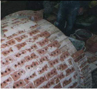
13 - costruzione dell'arco terminale di completamento
