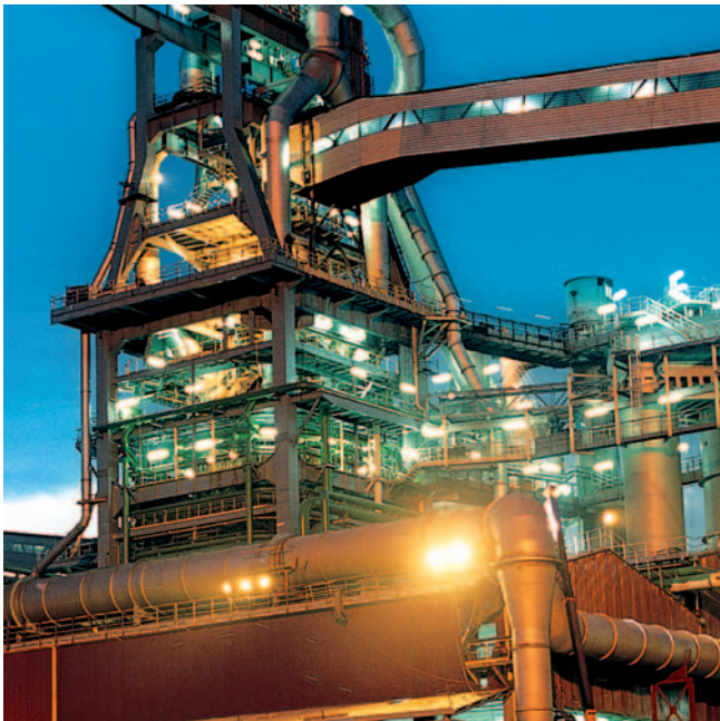
Aplicación industrial: Refinería
