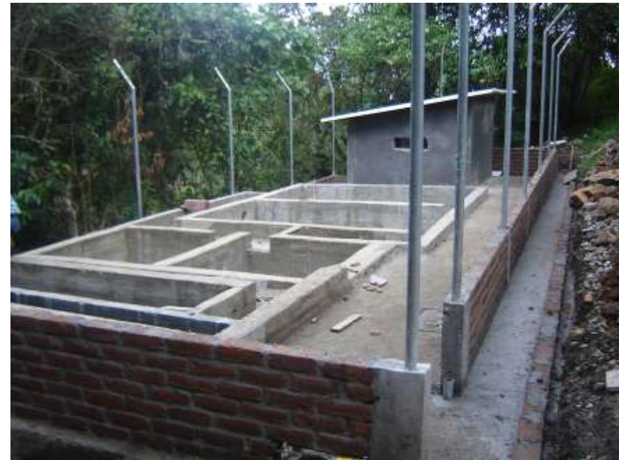
Adecuación Planta Tratamiento Agua Potable Vda. Gualanday
