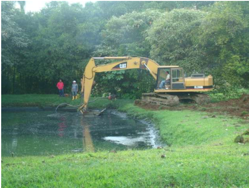
Limpieza y Mantenimiento Laguna oxidación Chontaduro
