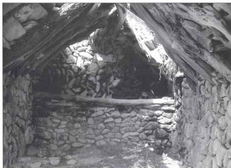
Interior d'una barraca de roter amb la menjadora i el coster situats en un dels paraments laterals.
