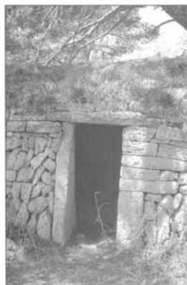
Portal amb una de les branques monolítiques.
