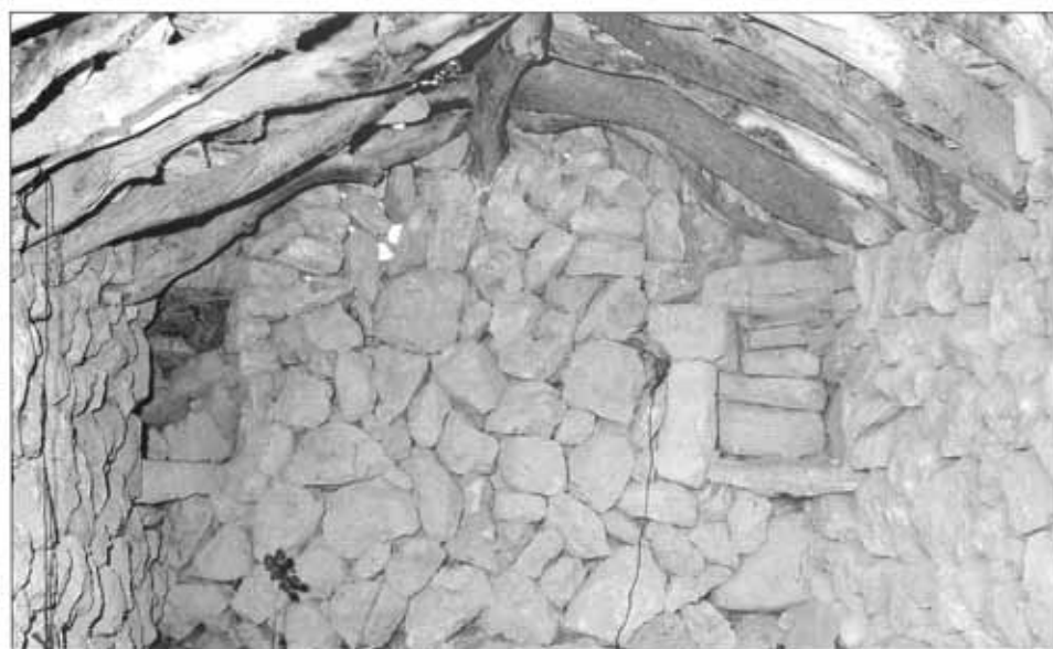
Rebosts situats a cada una de les raconades d'una barraca.
