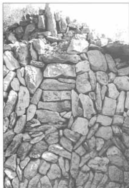
Peu de paret amb les pedres de pla on descansa la jassera principal.
