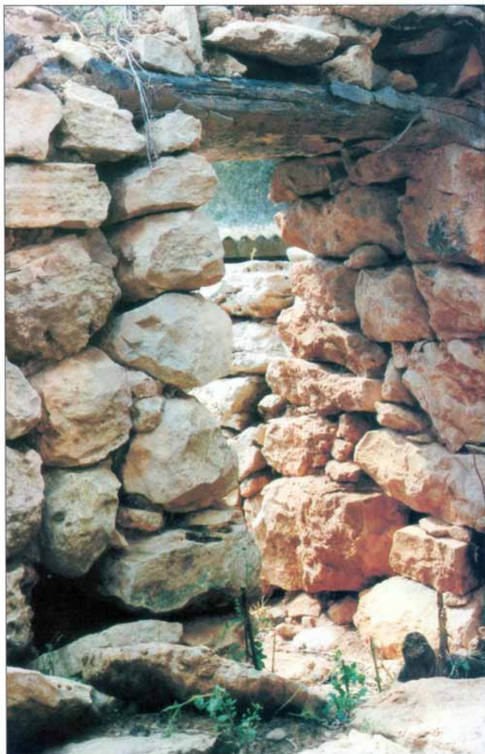
Portal d'una barraça de roter on la llinda interior és un tronc d'ullastre.
