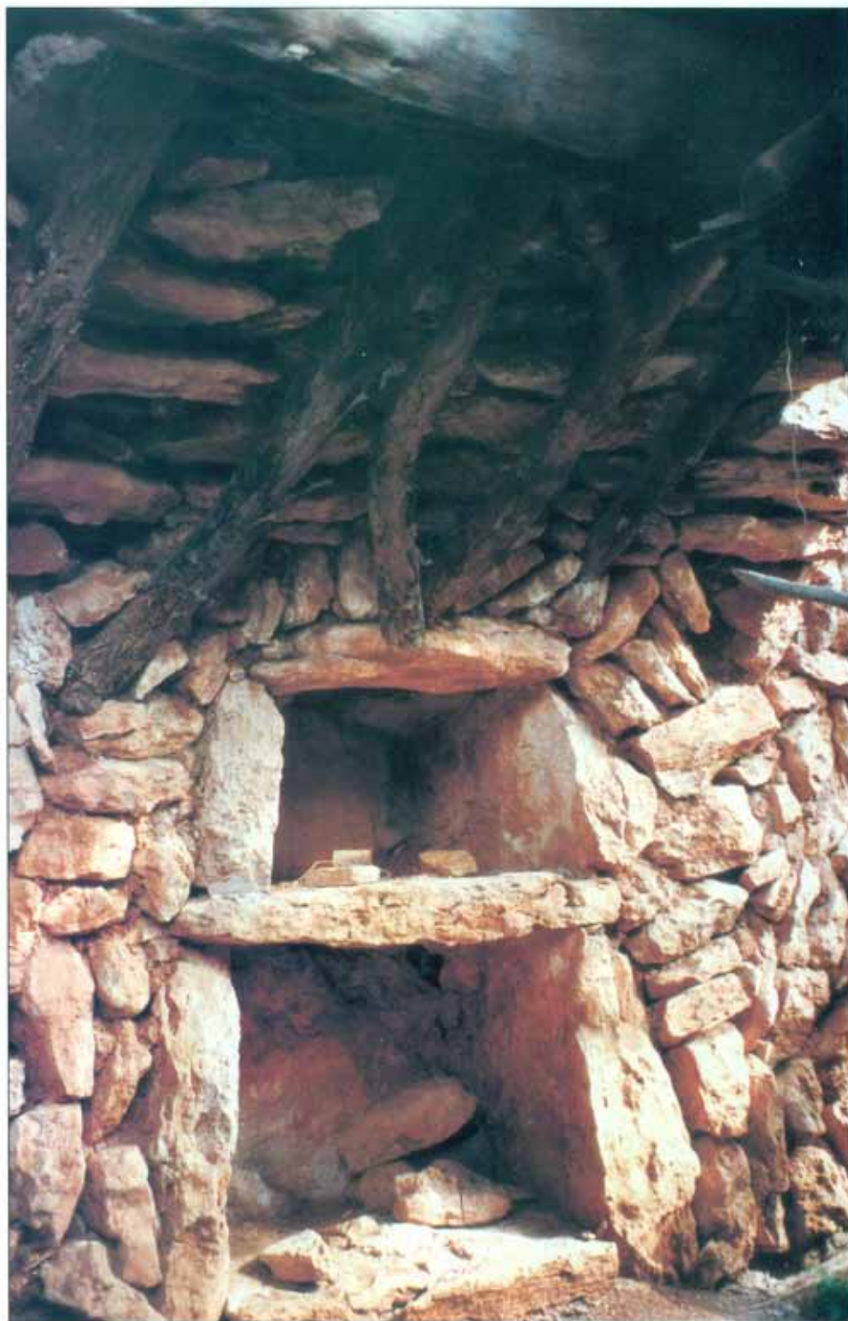
Rebosts superposats a l'interior d'una barraca de roter.
