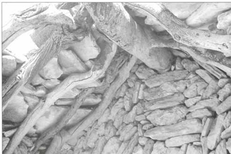
Cap de jassera principal que descansa damunt el peu de la paret lateral, la qual serveix de reforç.
