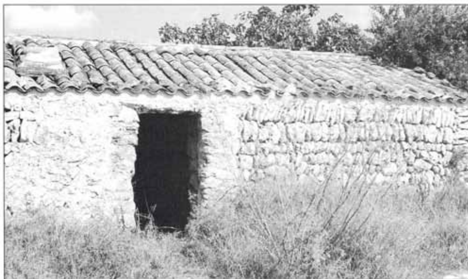
Amb el temps, la coberta de lloses s'ha substituït per una de teules.
