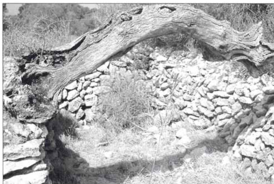
Jàssera transversal d'una barraca de roter.
