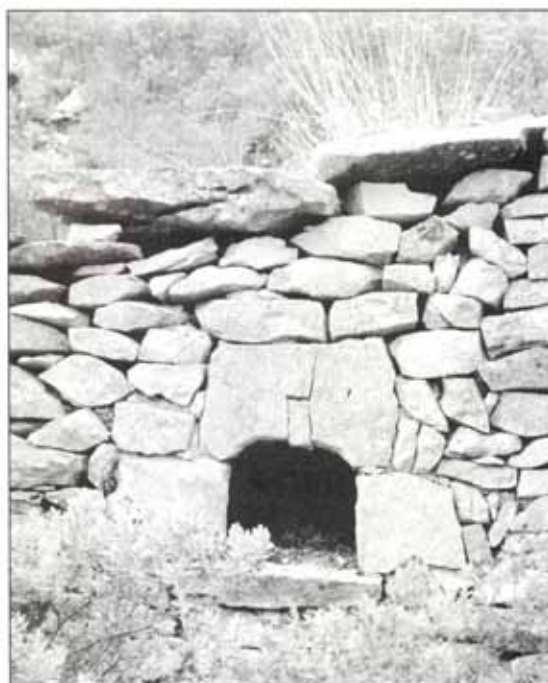
Forn construït de paret seca.
