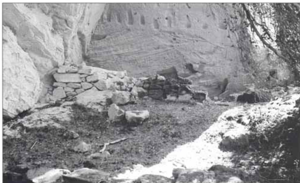
Barraca de trencador de Son Granada on podem observar part de la paret seca i en els talls de la pedrera el lloc on descansaven els caps dels llenyams de l'embarrat.
