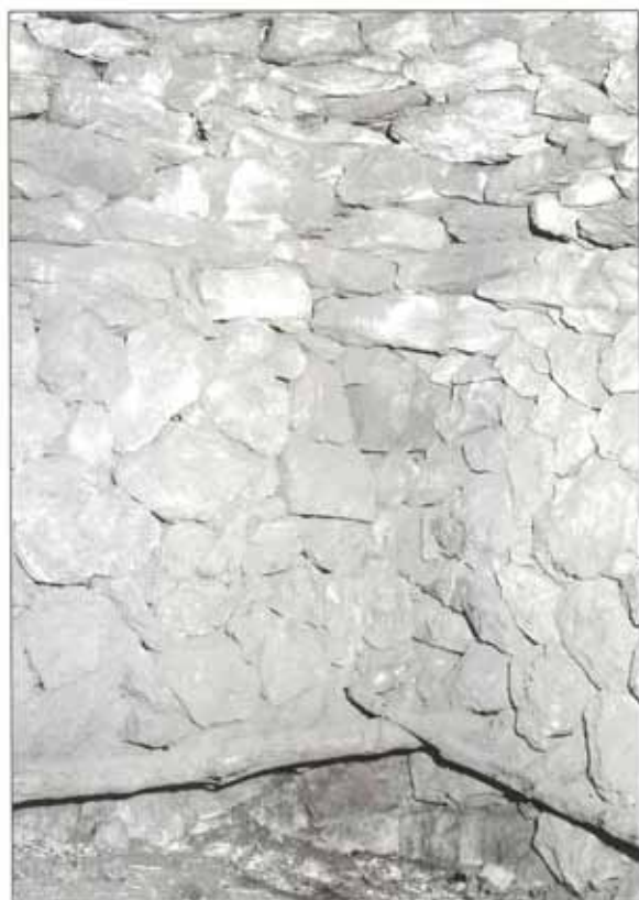
Troncs d'ullastre de cap a cap de paret d'una barraca de porcs que serveixen per evitar que la truja faci malbé els porcells
