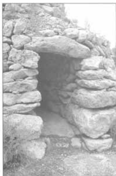
Portal amb les branques plurilítiques i amb el lllindar de pedra viva.
