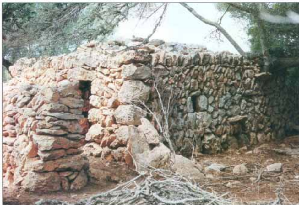
Sestadors amb la coberta de falsa volta amb un pujador i finestró.
