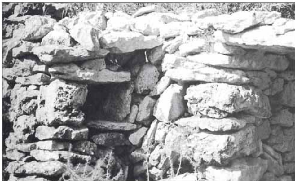
Rebot situat en un pujador adossat a la paret externa de la barraca.
