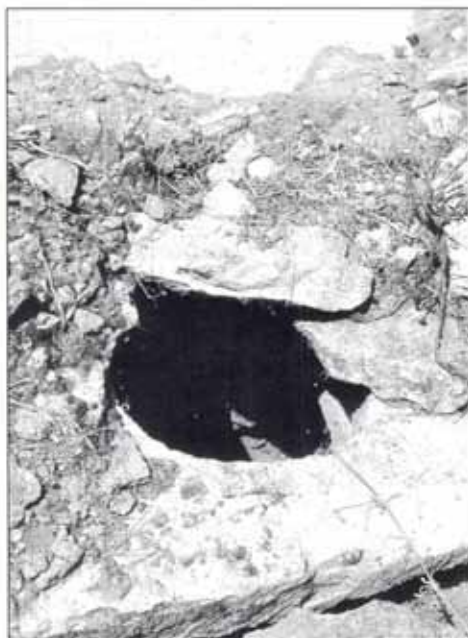
Xemeneia feta dins la paret, a l'esquerra. A la dreta, pedra planera foradada que servia per deixar sortir el fum de la foganya.
