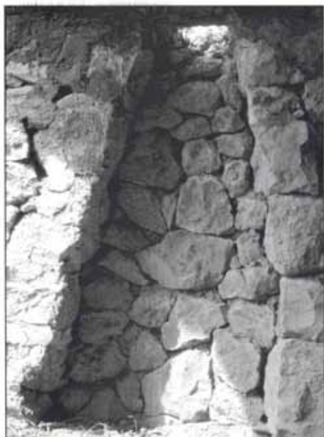
Xemeneia feta dins la paret, a l'esquerra. A la dreta, pedra planera foradada que servia per deixar sortir el fum de la foganya.
