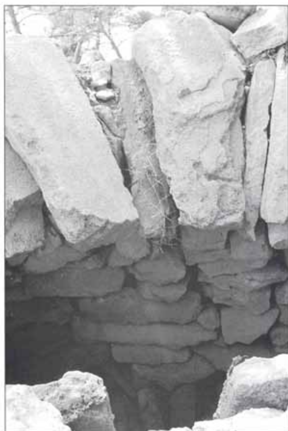
Posició vertical de les pedres maresenques de la barraca de volta falsa de Na Felia (s'Estalella).
