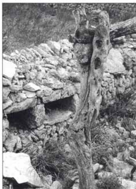
Recolzament del cap d'una jàssera principal que descansa damunt un puntal, a l'esquerra. Enganx de dues jàsseres amb un punxó fet d'ullastre, a la dreta.
