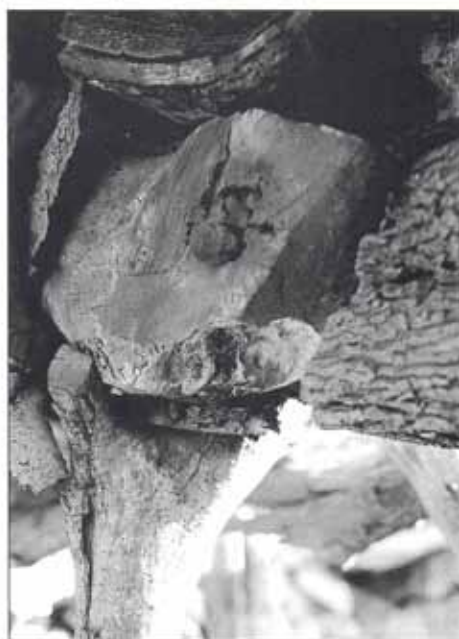
Recolzament del cap d'una jàssera principal que descansa damunt un puntal, a l'esquerra. Enganx de dues jàsseres amb un punxó fet d'ullastre, a la dreta.
