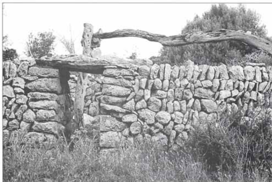
Jàssera principal que descansa damunt un puntal d'ullastre.
