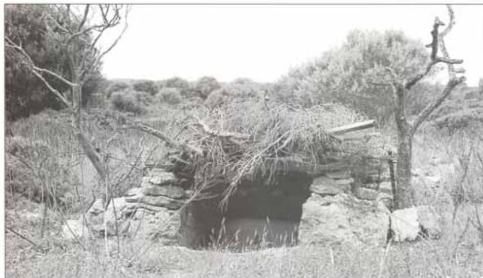
Bassa tapada amb coberta de brancatge.
