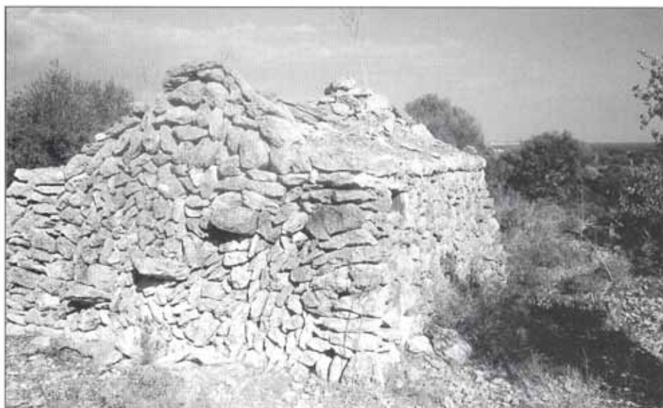
Façana posterior i paret lateral de la barraca de garriguer del Claper Rodó de s'Estalella. Hi podem observar els escalons per pujar i el finestró.
