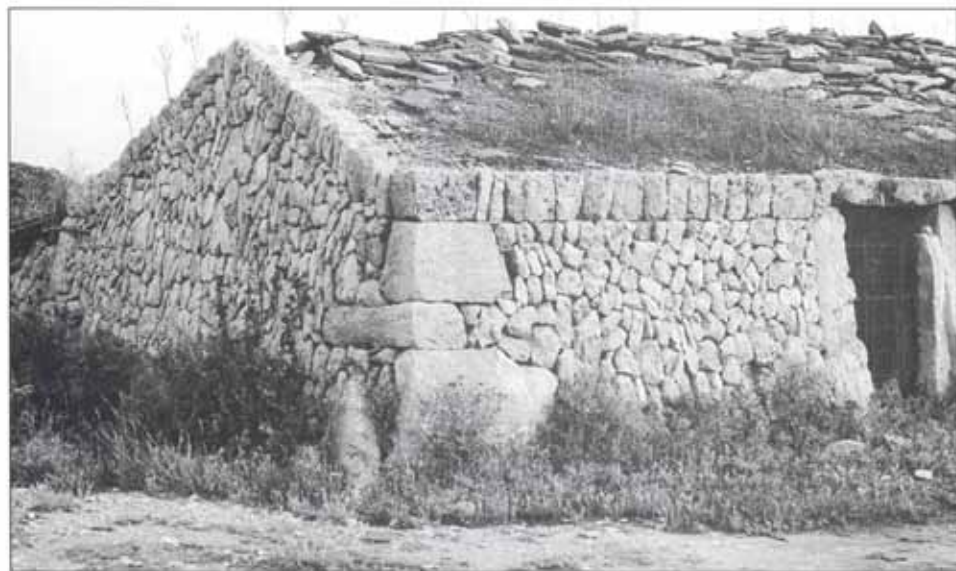
Barraca de s'Àguila, amb un escopidor a la seva cantonada.
