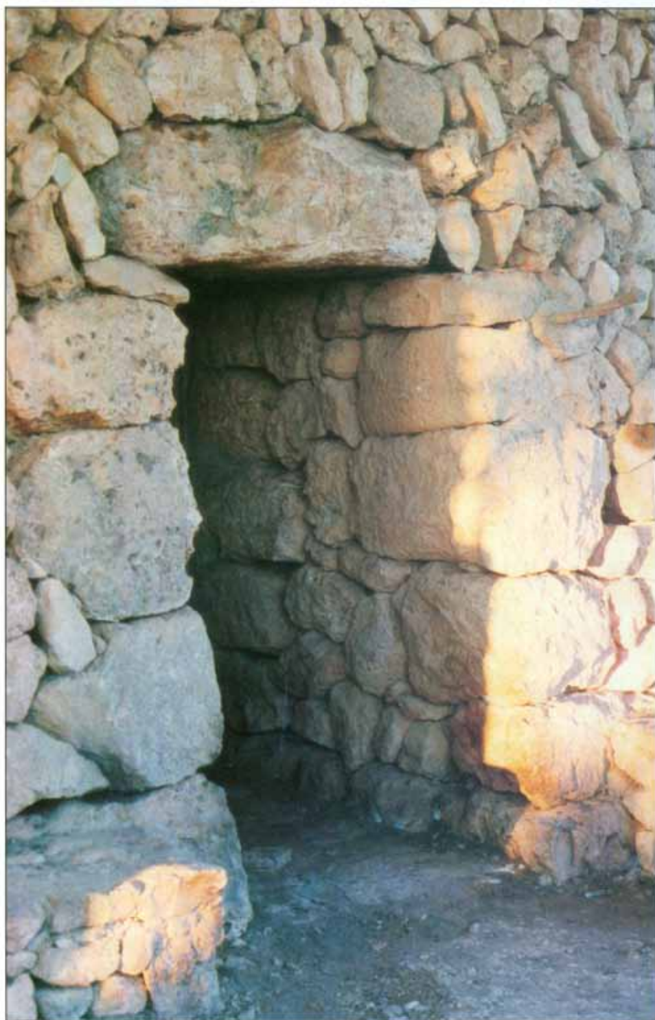
Portal amb les branques plurilítiques d'una barraca de Son Julià.
