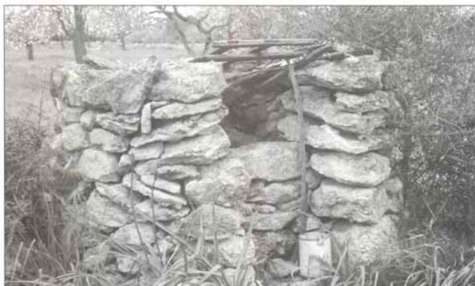
Cisterna amb el coll de pedra en sec.
