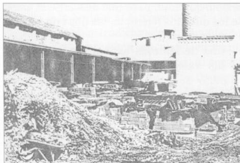
Se empezaba quemando la cal viva, para convertirla en cal común, para mezclarla con arena, en la proporción dos de arena y una de cal, y una de cal y una de arena.
