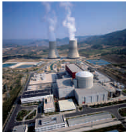
③ Central nuclear de Cofrentes. Se encuentra en el margen derecho del río Júcar, al oeste de la Comunidad.
