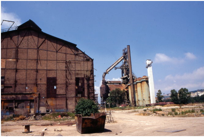
01 | Lo stabilimento siderurgico dell'Ilva a Bagnoli (Napoli) dopo la dismissione: centrale termica (1910) e altoforno (1935)
