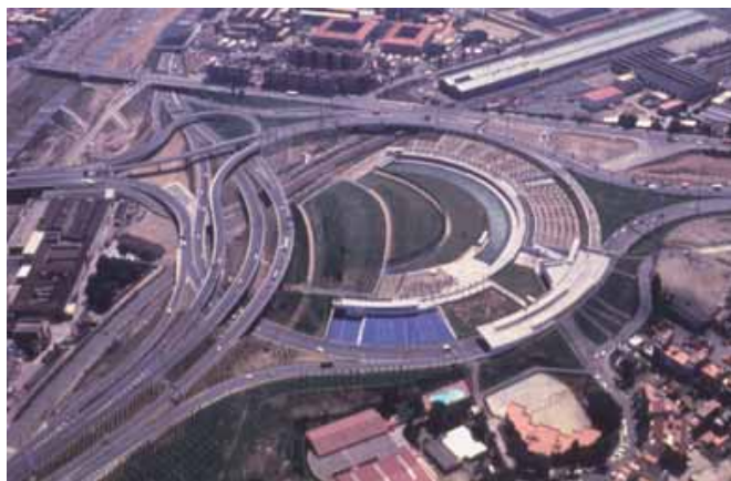
Fig. 5. El nudo de la Trinitat en Barcelona: propuesta del PGM y solución construida.
