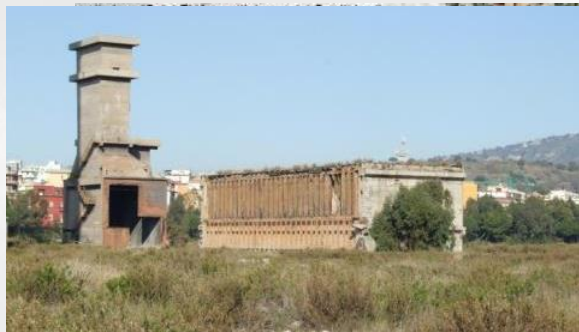
4, 17 Torre di spegnimento, batteria coke
