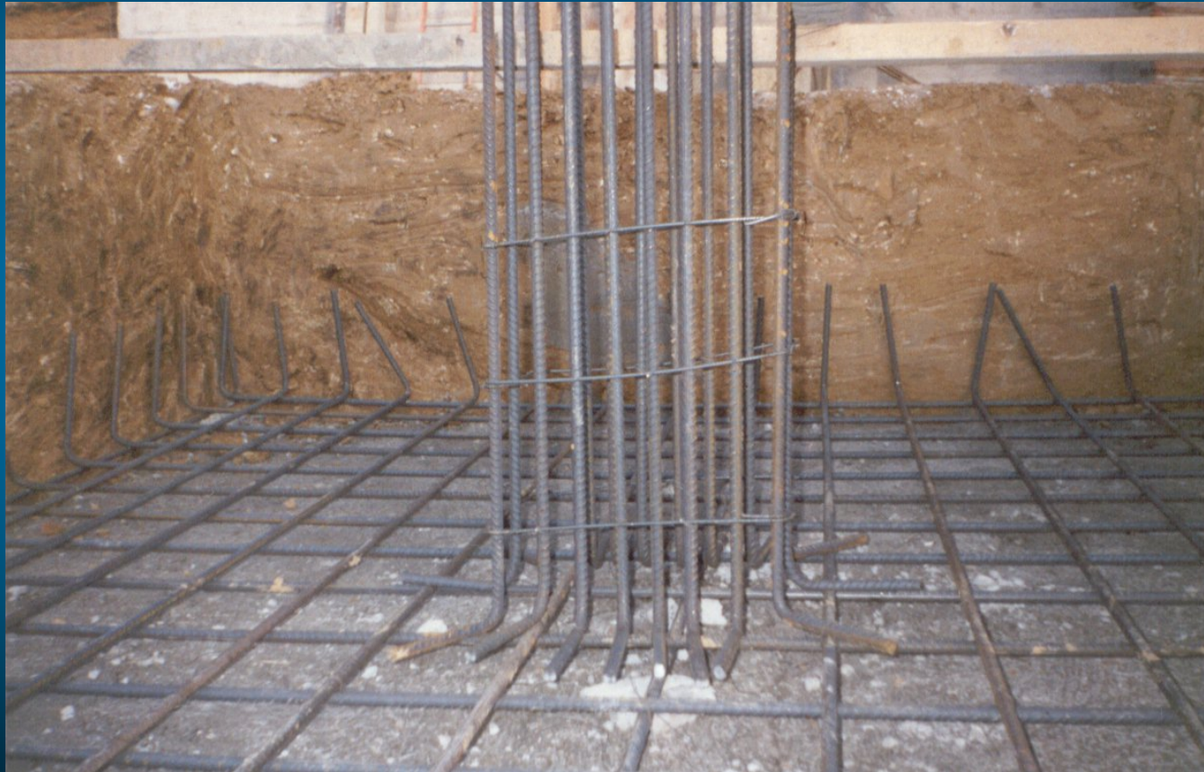
ARMADURA DE ESPERA DE PILARES
