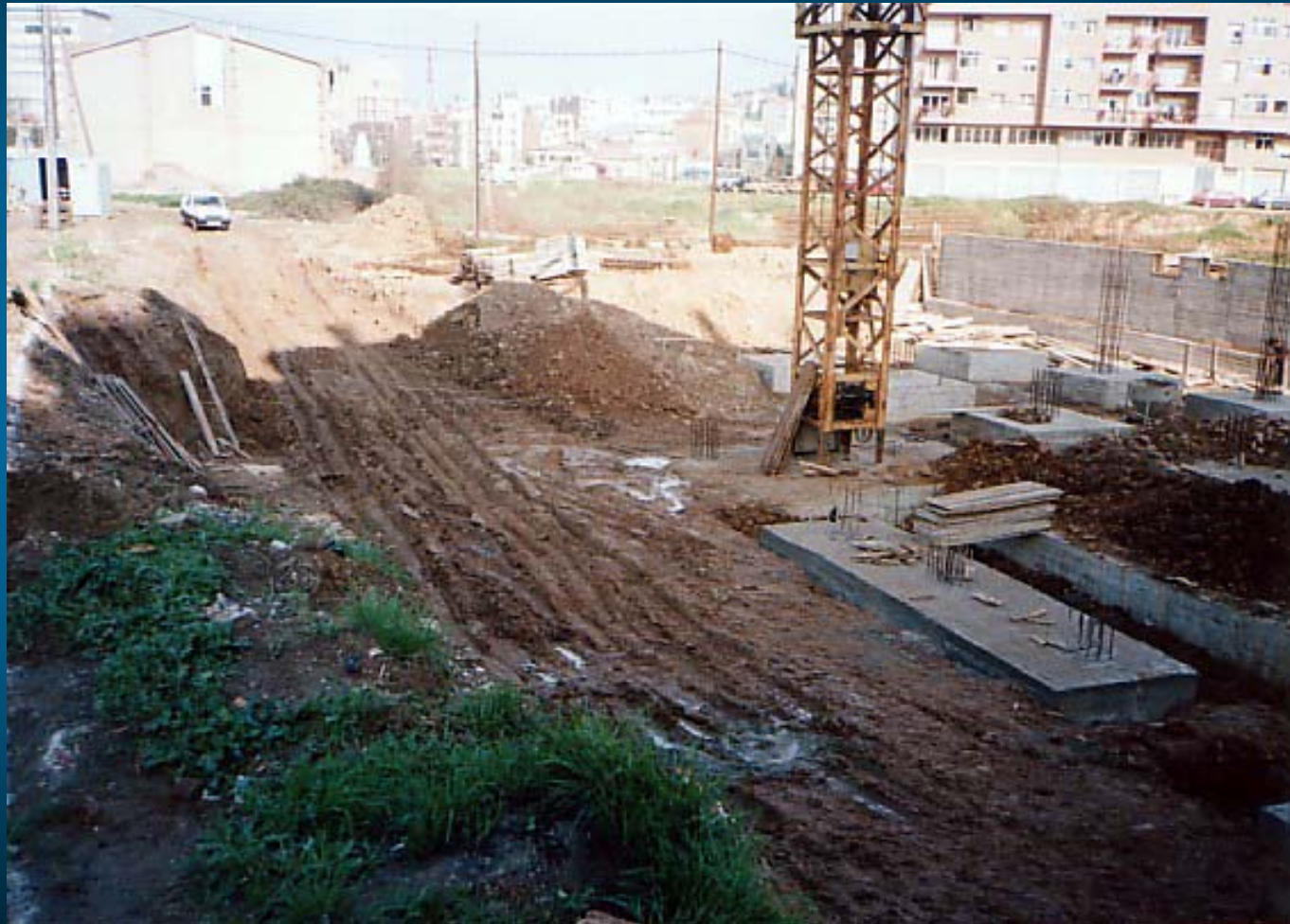
ZAPATA CORRIDA DE TRES PILARES
