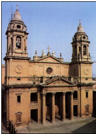
6. Fachada de la cat. de Pamplona. Ventura Rodríguez.
